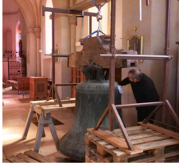
30. März 2020 Maßnahmen im Münster am Glockenjoch der Tuba Dei für die Stahlachse
