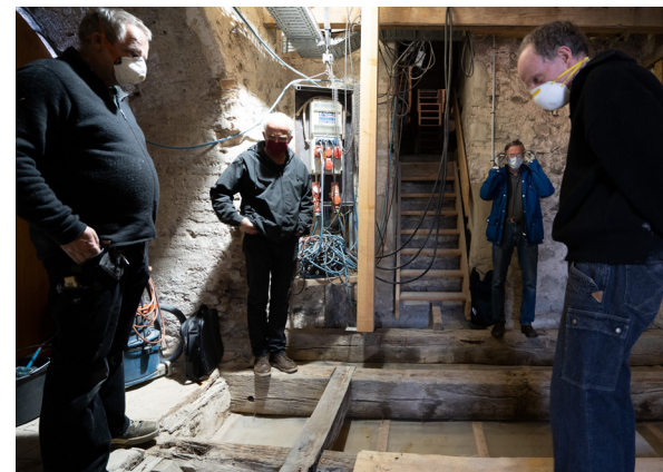
Nordturm: Balkenlage unterhalb der Glockenstube aus dem 12. Jahrhundert
