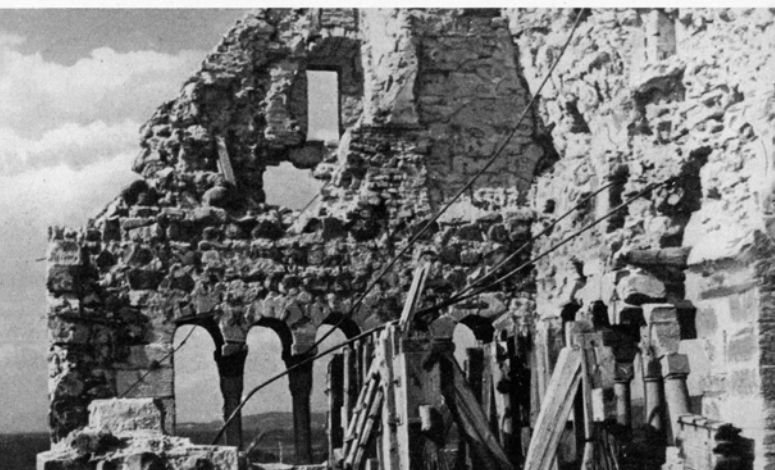
Nordturm - abgeschossener Turmhelm mit freiliegendem Glockenstuhl
