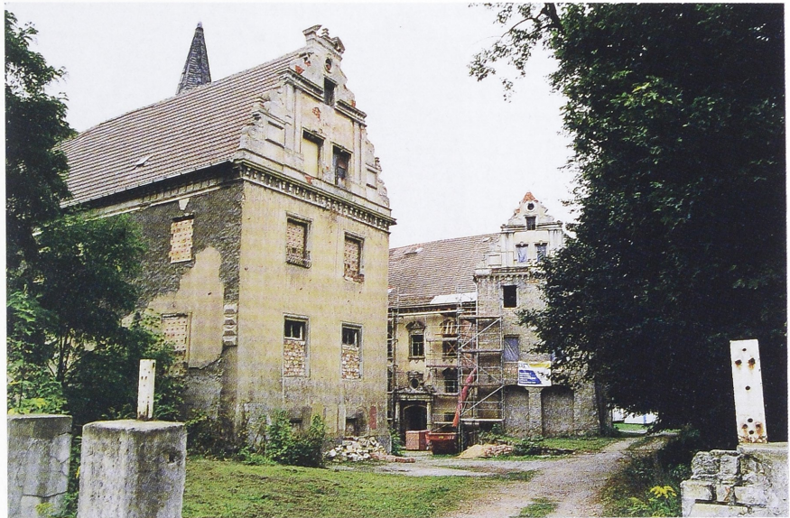
Abb. 3. Schloss Dieskau während der Sanierung (Foto: Udo Stephan).
