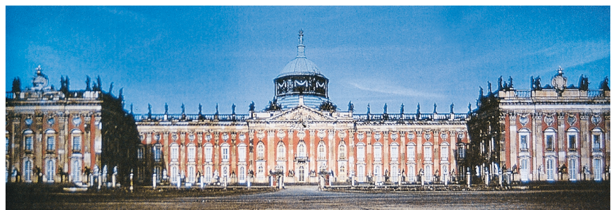
Abb. 2. Vom Hausschwamm in seinen Holzteilen zerfressen: das Neue Palais in Potsdam (Foto: Stiftung Preußische Schlösser und Gärten).
