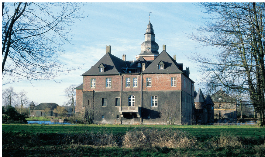
Abb. 1. Haus Sandfort von Osten, bestehend aus Häusern des 16./17. Jahrhunderts mit vorgeseztem Torturm und Westflügel vom Ende des 17. Jahrhunderts. 1912 verändert und nach schweren Kriegsschäden bis 1953 wiederaufgebaut (Foto: Verf.).
