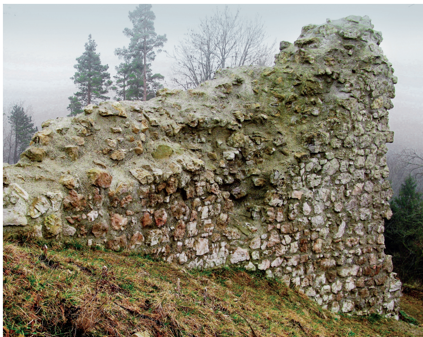
Abb. 1. Innenseite der Hauptmauer, Zustand Februar 2011 (Foto: Verf.).
