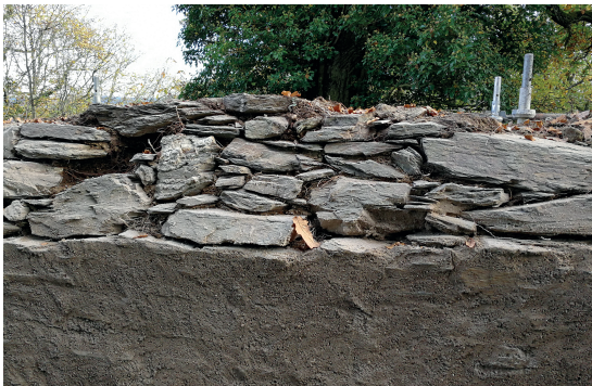
Abb. 2. Detail der Mauerkrone („Bischofsmütze“) der südöstlichen Zwingermauer (Foto: 18. Okt. 2017).
