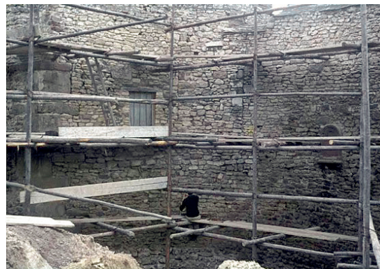
Abb. 6. Aula regia, Apsis, Mauerwerksuntersuchungen 1965. Uta Weimann (sitzend auf der untersten Gerüstlage) bei der Erstellung einer stein- und verformungsgetreuen Bauaufnahme (Foto: Unbekannt 1965).
