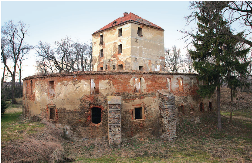
Abb. 13. Tepliwoda, Ansicht des Wohnturms (Foto: Verf.).
