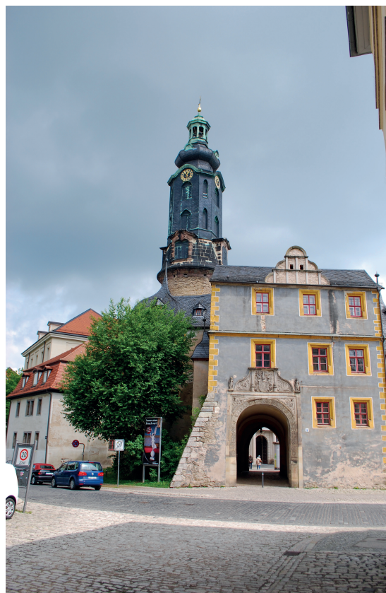
Abb. 1. „Bastille“ am Stadtschloss in Weimar von Westen mit Hofdamenhaus, Torhaus und Hausmannsturm (Foto: Verf.).
