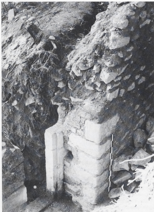
Abb. 9. Freilegung des Torhauses. Spätgotische Pforte zum Zwinger, Wachraum mit Steinbank 1986.
