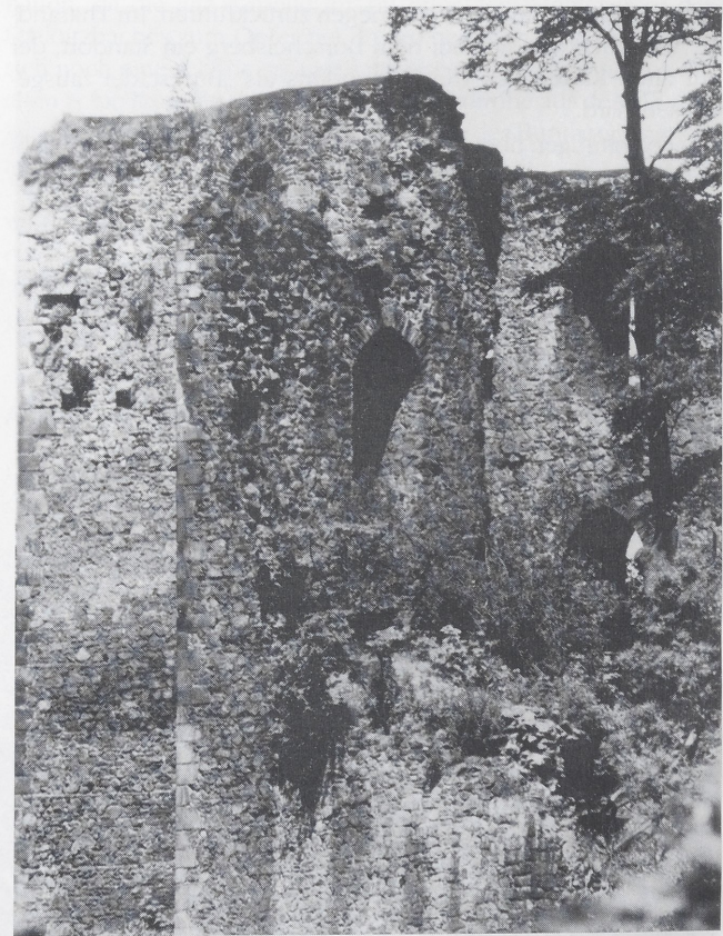
Abb. 7. Blick auf die bestehenden Umfassungswänden von Palas und Südturm (Kapellenturm) 1980 nach Freilegung vom Baumbewuchs.
