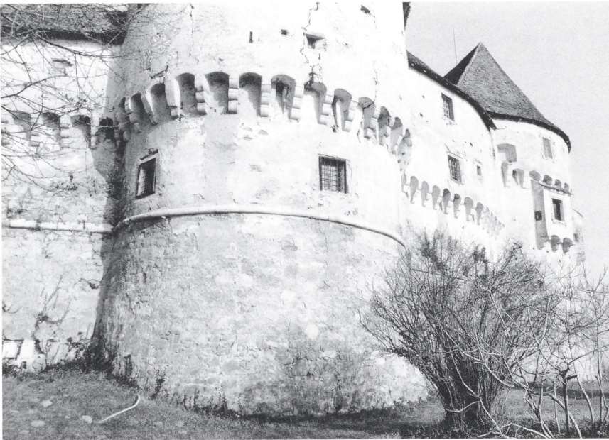
Abb. 7. Der Ring mit dem südlichen und östlichen halbkreisförmigen Turm.
