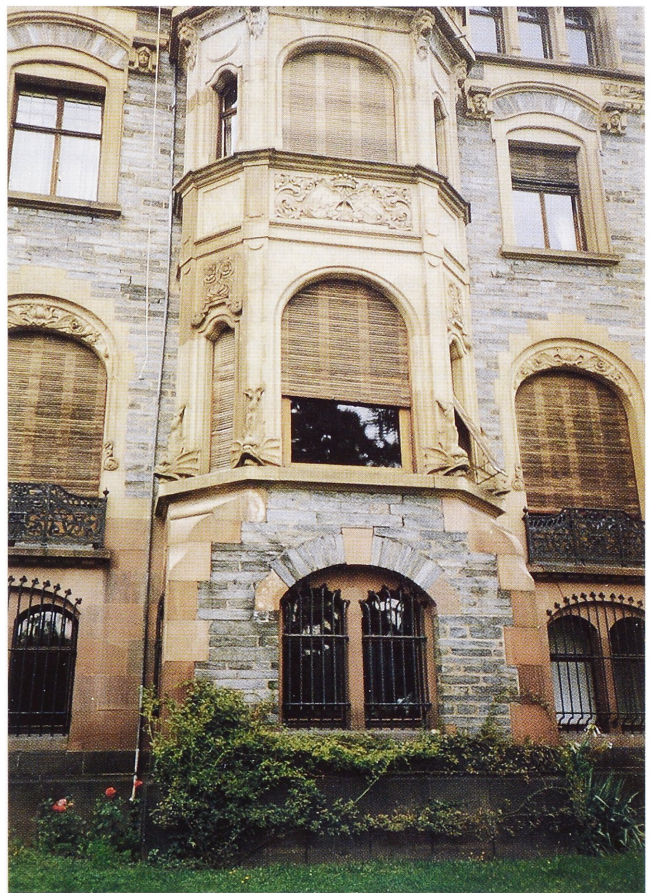
Abb. 4. Haus Puricelli, Erweiterungsbau von 1895/1906, Hauptfassade, Teilansicht von Süden (Foto: Verf., 1988).
