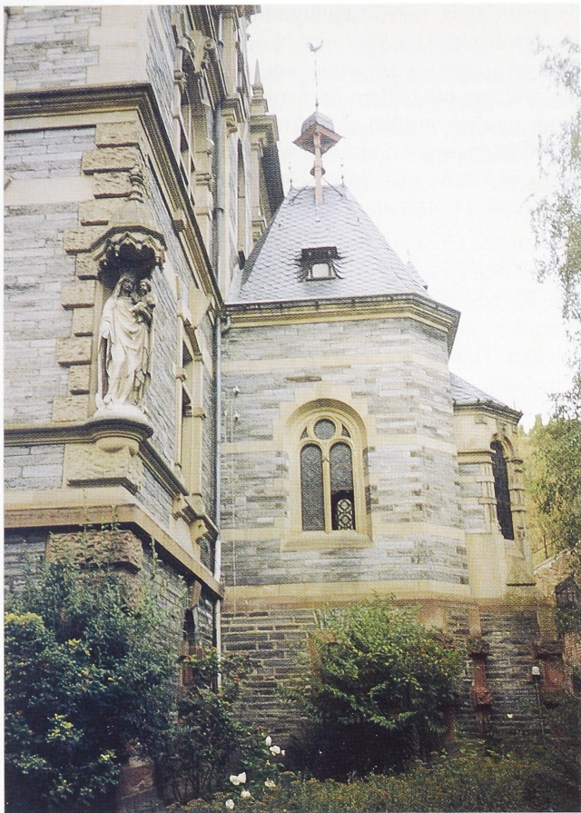
Abb. 3. Haus Puricelli, Kapelle von Süden; links am Hauptgebäude die vom "Kölner Dombildhauer" Prof. P. Fuchs (1829–1898) geschaffene Madonnenstatue (Foto: Verf., 1988).
