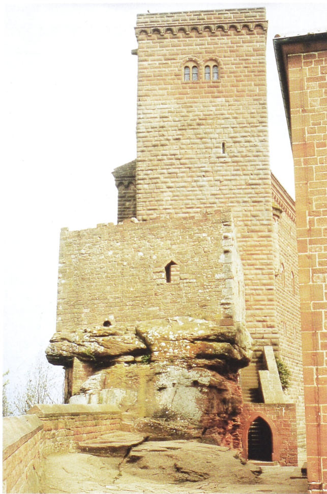
Abb. 3. Ausgang und Turm des Trifels mit Kapellenerker. Auffallend sind die langgestreckten Quader im unteren Turmbereich. Die Aufstockung des Turmes ist an der dunkleren Farbe erkennbar (Foto: Verf.).
