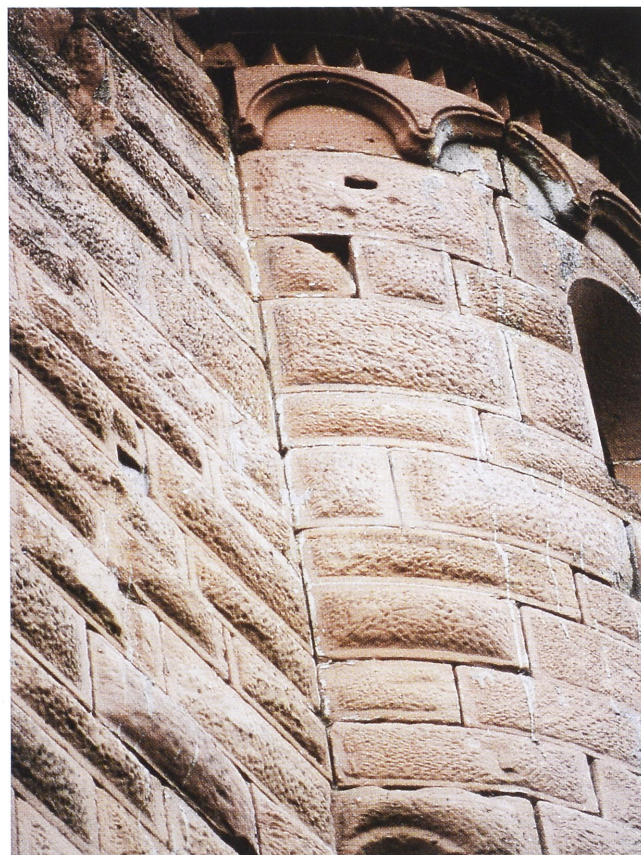
Abb. 8. Der Kapellenerker von Süden. Die unterschiedlichen Schichthöhen zwischen Erker und Turmmauerwerk, besonders im oberen Bereich, sind klar zu erkennen (Foto: Verf.).
