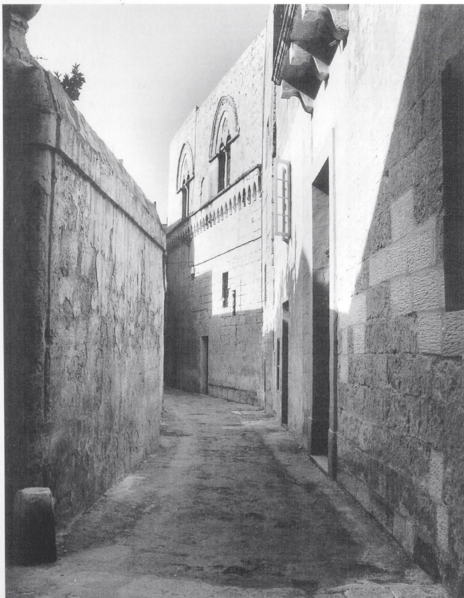
Abb. 15. Mdina, Palazzo Gatto Murina, Hauptfassade mit Biforienfenstern (Foto: Verf. 1994).
