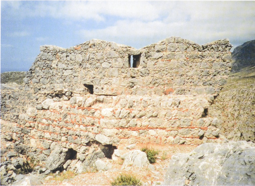
Abb. 2. Kálymnos, Chóra, Kástro, Teilstück der Ringmauer mit Wehrgang. Die Zinnenform gilt als architektur-ikonologisches Herrschaftszeichen der Johanniter. Die Ringmauer stammt in der Grundsubstanz aus byzantinischer Zeit (Foto: Verf., 1990).
