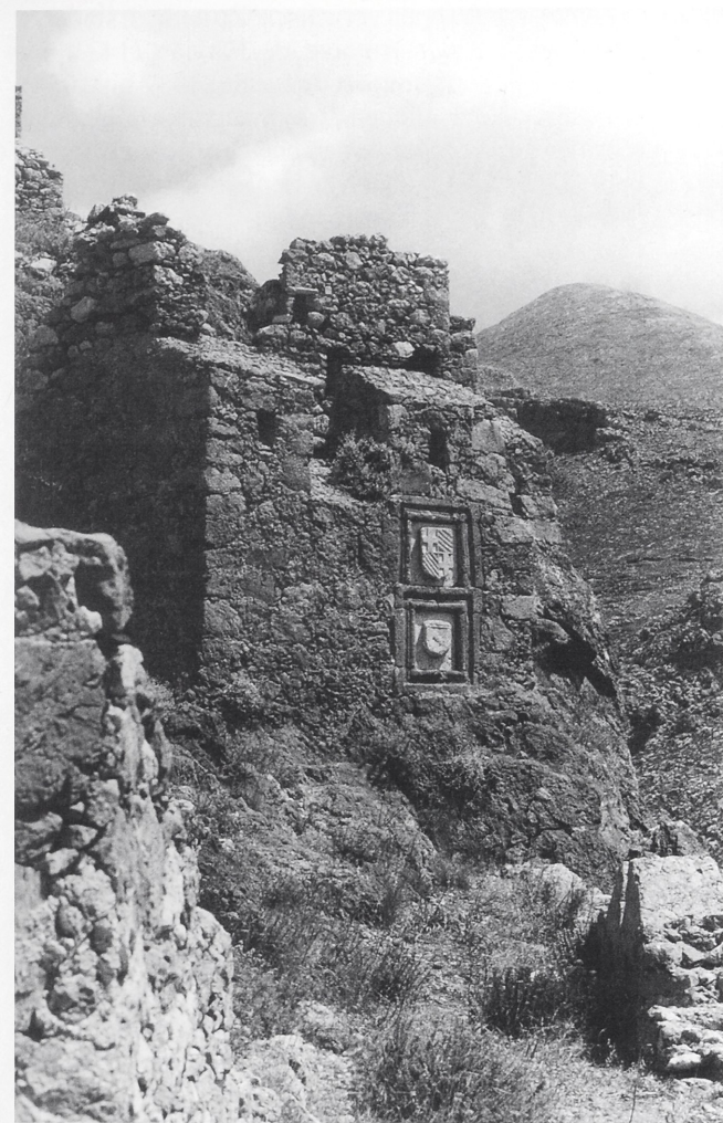
Abb. 4. Kálymnos, Chóra, Kástro. Geschützstellung an der Südostseite des Berings; feldseitig das (erneuerte?) Wapen des Großmeisters Fabrizio del Carretto (1467 bis 1476) sowie ein unbekanntes Wapen; die Brüstung in nachmittelalterlicher Zeit verändert (Foto: Verf., 1989).
