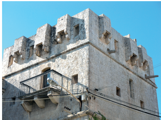
Abb. 4. Naxxar (Malta), Torre Gauci, Wehrplattform; der mittlere Wurferker mit figürlichen Konsolen (Foto: Verf.).
