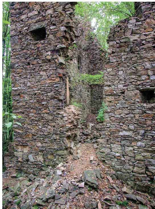
Abb. 4. (links) Südwestwand im Dezember 1983 mit erhaltener Türöffnung zum Erdgeschoss, darüber ein nicht verwitterungsbedingtes Wandloch, das möglicherweise als Balkenauflager diente.
