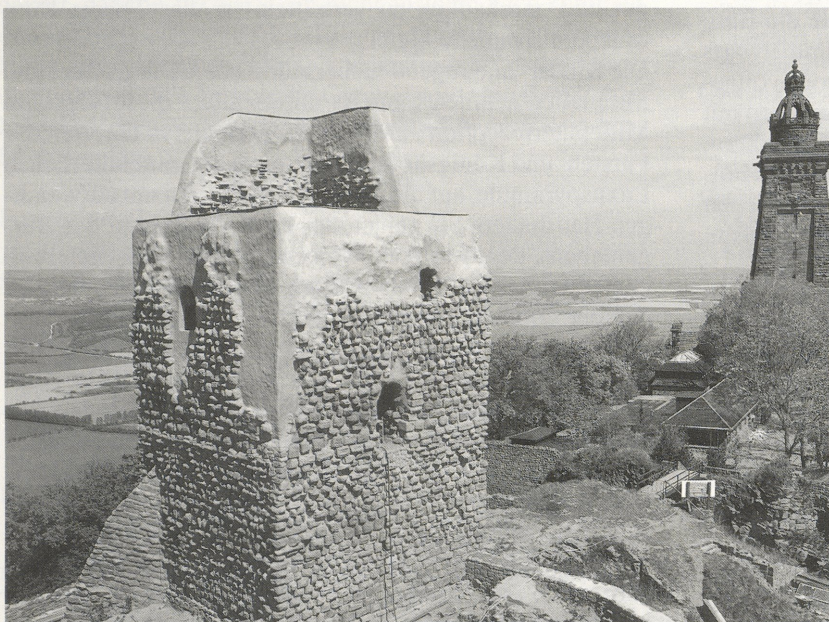
Abb. 1. Sanierung des Barbarossaturmes am Kyffhäuser (Foto: H.-P. Szyszka).
