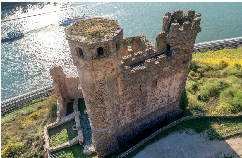
Abb. 5. (links) Blick auf Wehrgang und Türme der Schildmauer – der burgenkundlich bedeutsamste Teil von Ehrenfels; links der sanierte Mauerzahn von innen und die in den 1990er-Jahren auf den alten Fundamenten neu aufgemauerten Gebäudegrundrisse (Foto: 31.10.2019).
