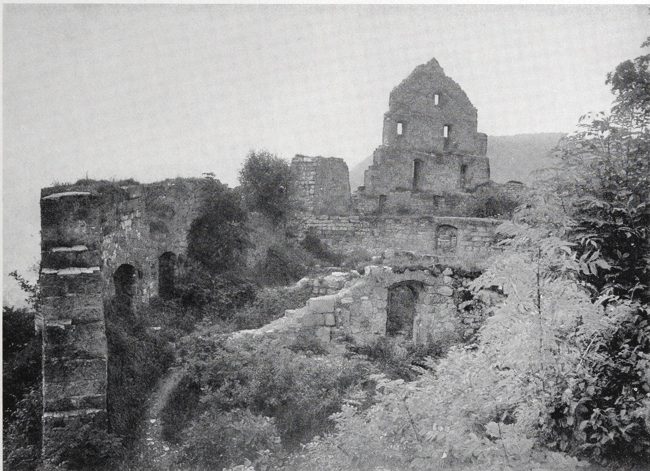
Abb. 5. Hohenurach. Innerer Hof mit Umfassungsmauer, Gebäuderesten und Giebel
