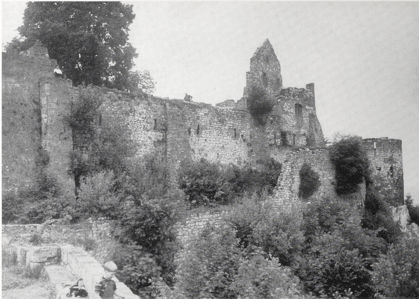
Abb. 8. Hohenurach. Umfassungsmauer und Giebel
