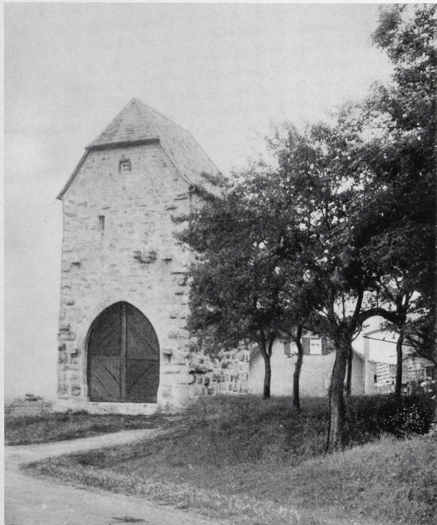
Abb. 13. Landturm bei Lichtel, Ansicht von außen mit rechts anschließendem Erdwall nach der Erneuerung
