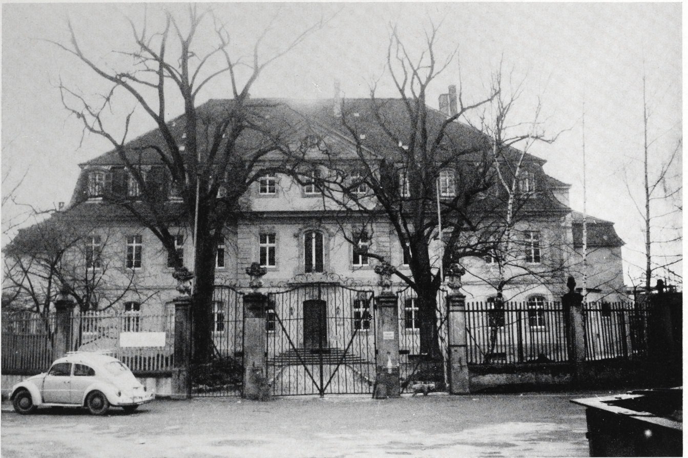
Abb. 5. Schloß Bönningheim, Eingangsseite nach der Erneuerung
