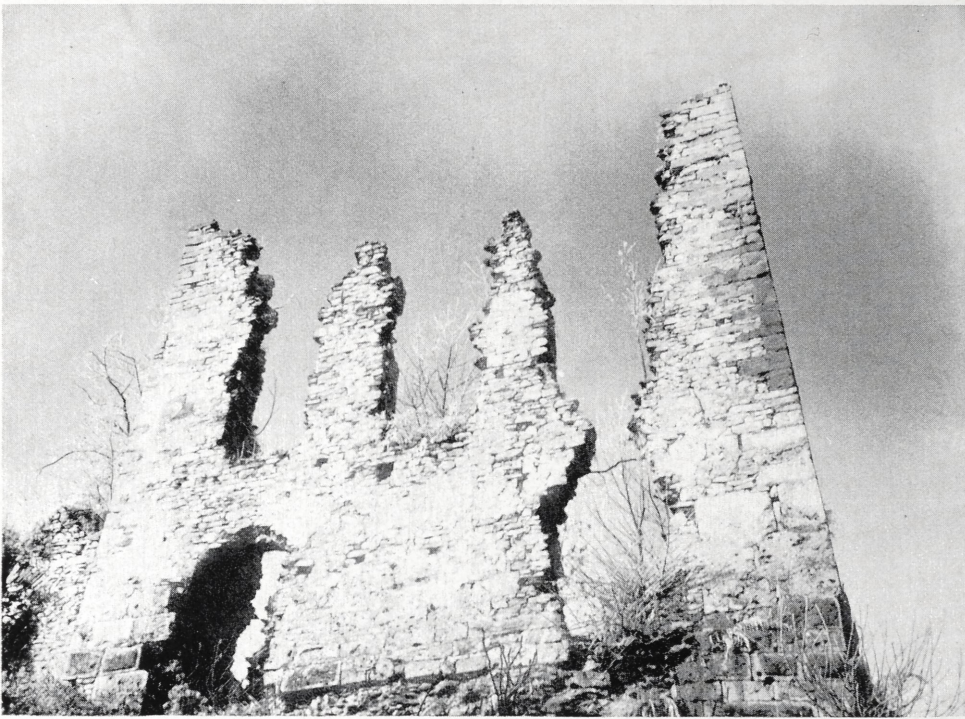
Abb. 15. Burgruine Lauterburg, Hauptbau gegen den Halsgraben vor der Erneuerung
