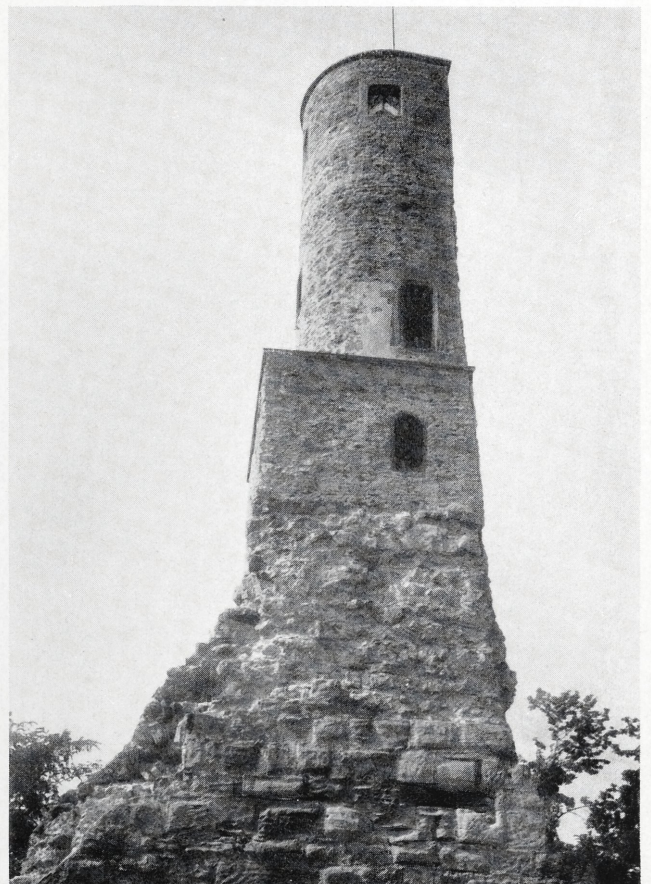
Abb. 14. Burgruine Löwenstein, staufische Mantelmauer mit später angebautem Treppenturm nach der Erneuerung
