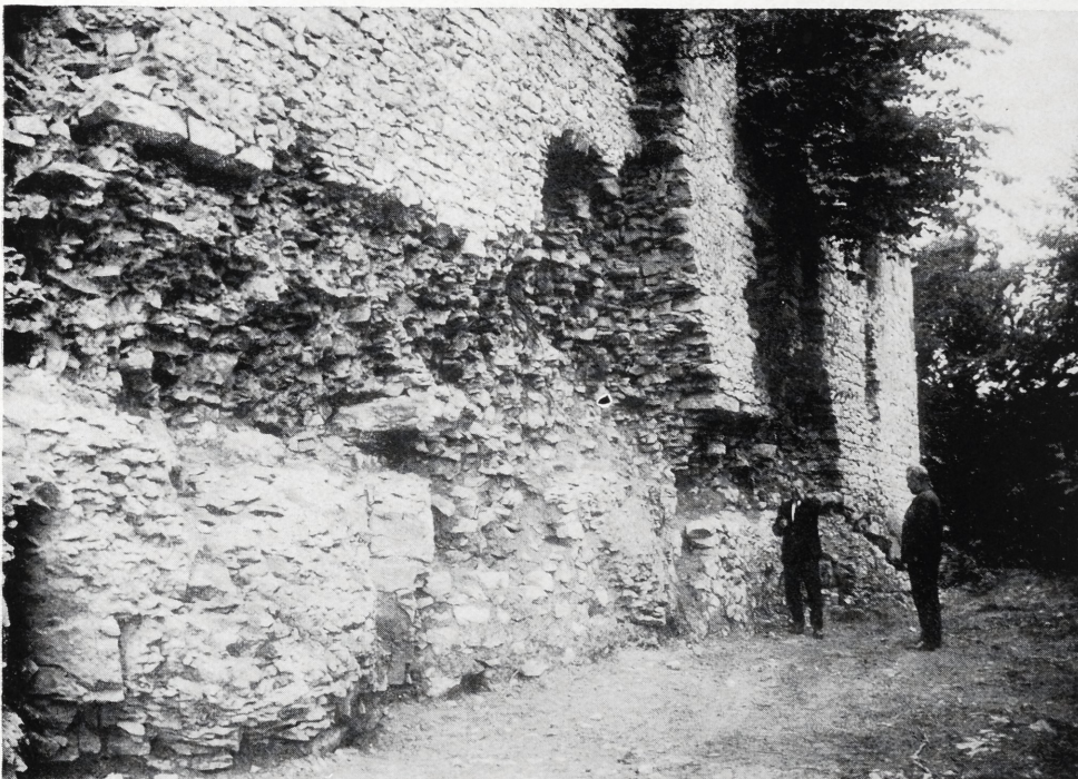
Abb. 16. Burgruine Lauterburg, Langseite des Hauptbaues mit abgewittertem Fels vor der Erneuerung
