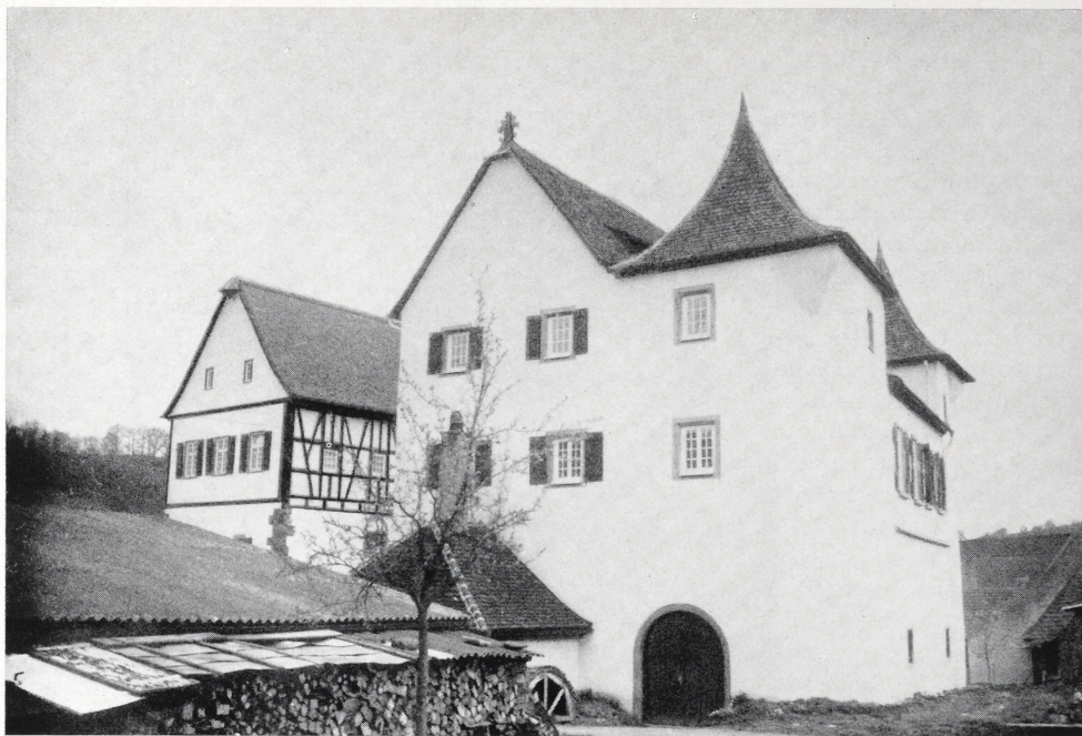
Abb. 10. Schloß Tullau, Ansicht von Südwesten nach der Erneuerung
