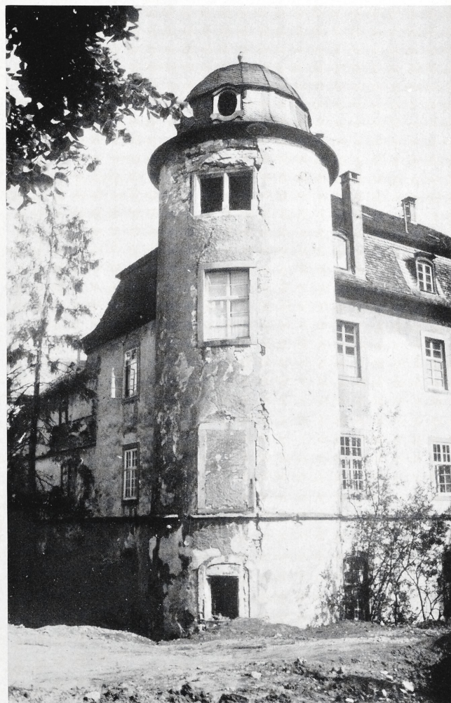
Abb. 3. Schloß Pfedelbach, Südwestturm vor der Erneuerung
