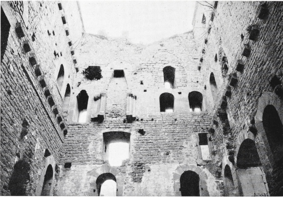
Abb. 13. Rathsamhausen, Inneres des Wohnturms, oberer Teil der Ostwand (Foto: Verf.)
