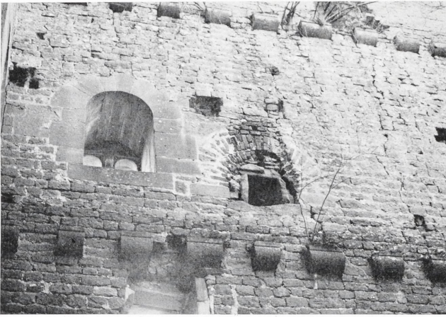
Abb. 17. Rathsamhausen, Doppelfenster und Heizungsanlage im 2. Obergeschoß, Innenseite (Foto: Verf.)
