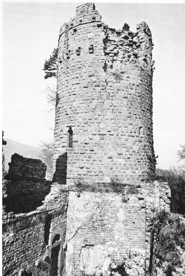
Abb. 21. Rathsamhausen, Bergfried von Süden (Foto: Verf.)
