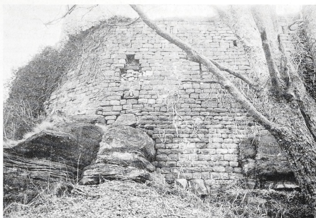
Abb. 23. Rathsamhausen, nördliche Ringmauer der Bürgerweiterung, östlicher Teil vom Graben aus (Foto: Verf.)
