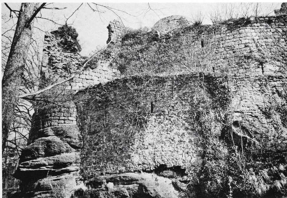
Abb. 24. Rathsamhausen, westliche Ringmauer der Bürgerweiterung mit Eckturm und Zwingermauer (Foto: Verf.)
