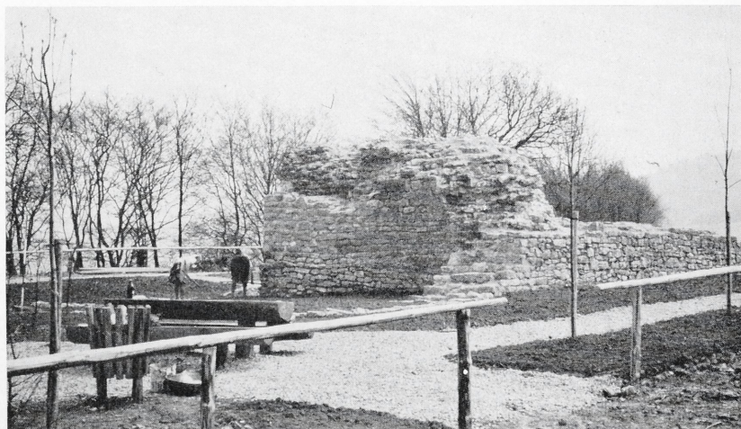
Abb. 5. Ruine Stein. Renovierte Ruine von Nordwest
