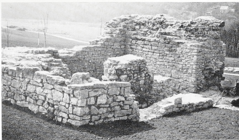
Abb. 4. Ruine Stein. Renovierte Ruine von Südost
