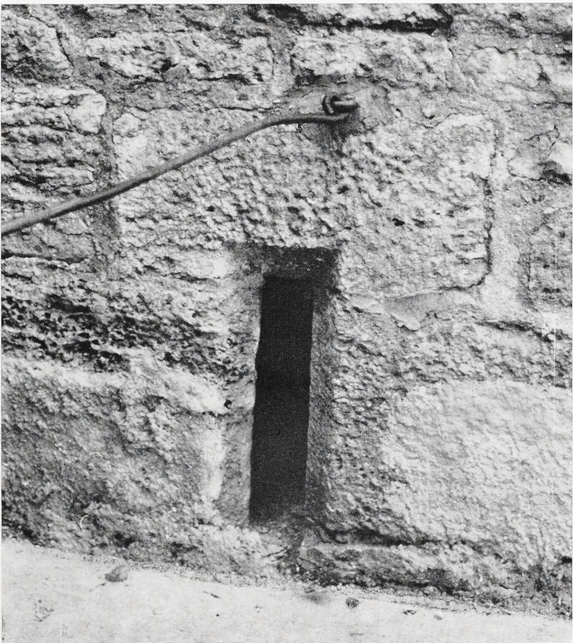
Abb. 12. Lichtschlitz in der Nordwand der Kernburg
