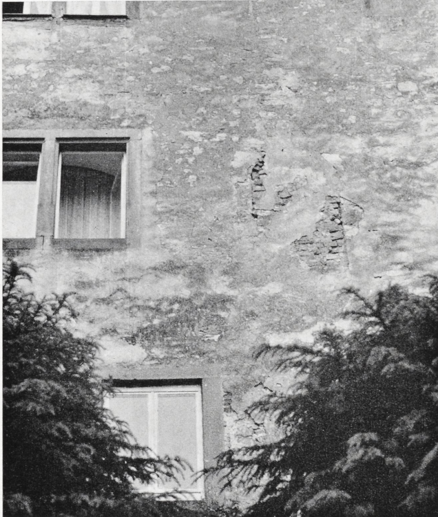
Abb. 15. Südwand der Kernburg, vermauerte Rundbogenöffnung in Höhe des ersten Obergeschosses
