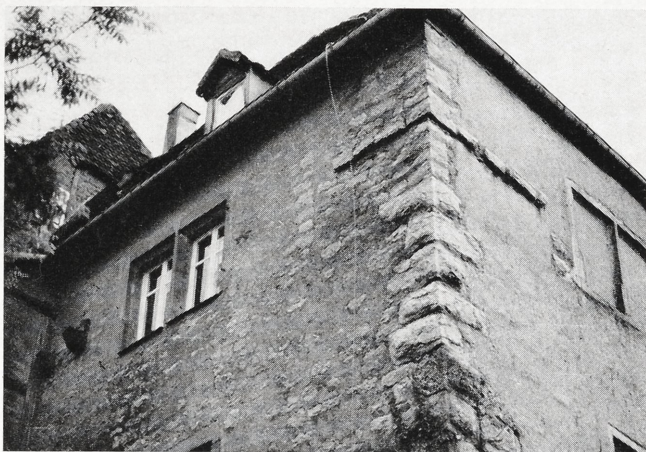
Abb. 13. Nordwestecke der Kernburg, oberer Teil
