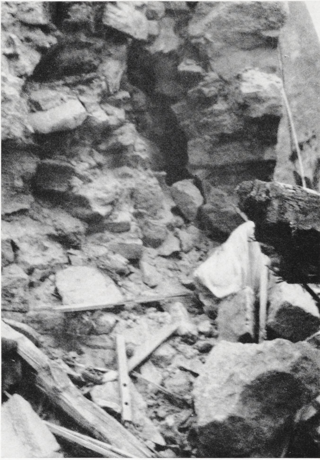
Abb. 3. Der Querschnitt der talseitigen Längswand des Osttraktes der Burg. Die dunkle Stelle oben in Bildmitte ist ein Loch mit etwa 20 \times 80 cm Querschnitt, das fast 2,0 m tief in die Mauer hineinragte
