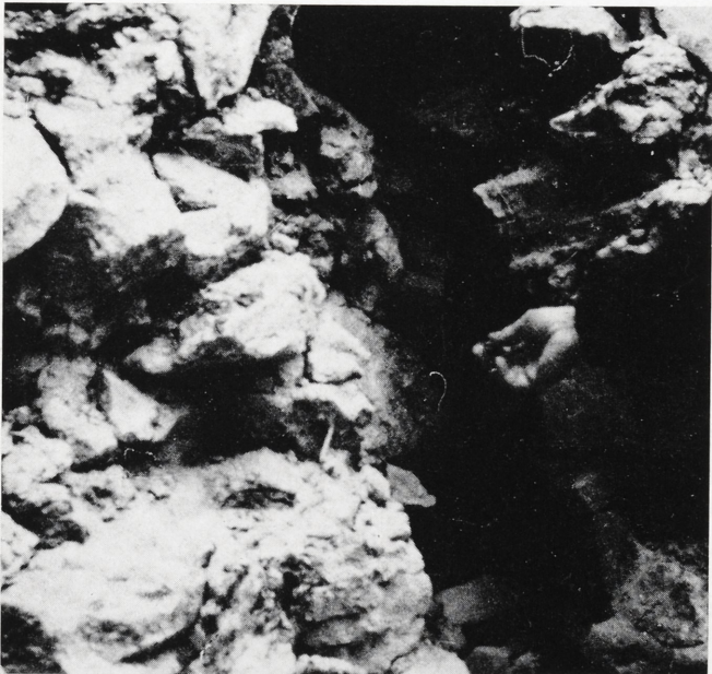
Abb. 4. Der Querschnitt der talseitigen Längswand des Osttraktes der Burg. Die Hand in Bildmitte zeigt ein Loch mit etwa 20 \times 80 cm Querschnitt, das fast 2,0 m in die Mauer hineinragte
