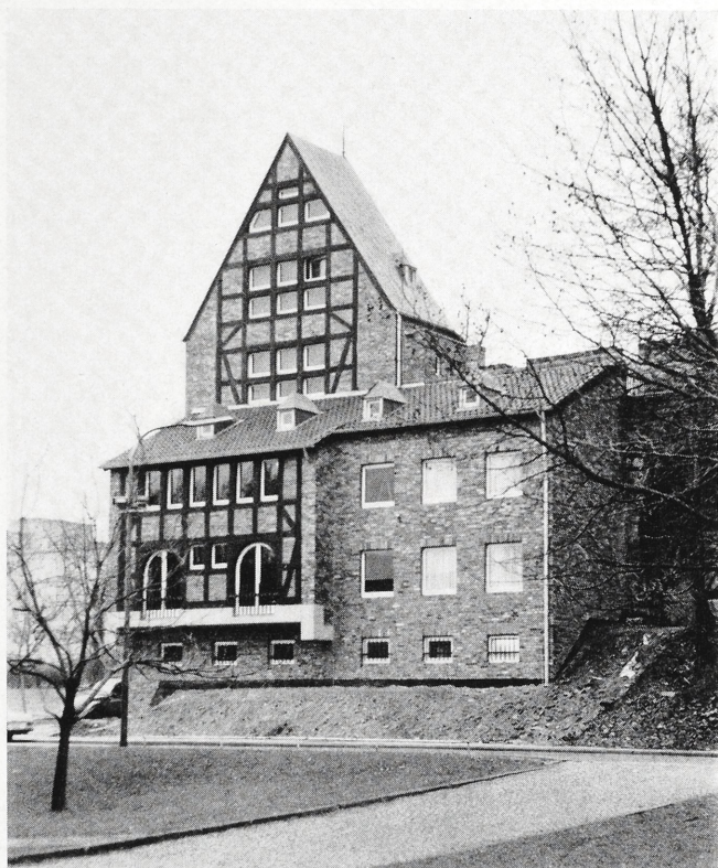
Abb. 2 und 3. Der Sachsenturm in Köln. Hier wurde das Fachwerk der alten Dombauhütte verwertet
