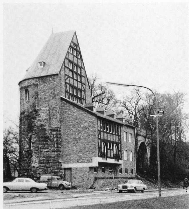
Abb. 2 und 3. Der Sachsenturm in Köln. Hier wurde das Fachwerk der alten Dombauhütte verwertet
