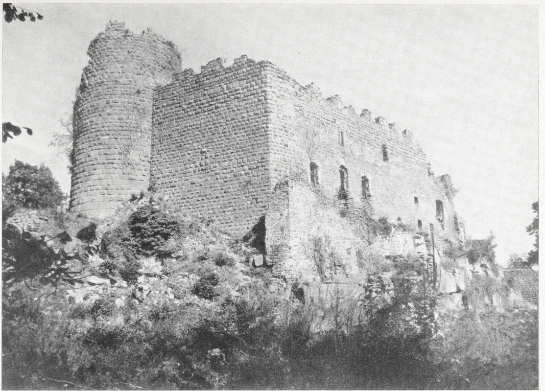
Abb. 3. Lützelburg, Kernburg von Süd- westen (Foto: Verf.)
