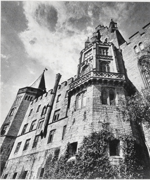
Abb. 9. Hohenzollern. Teil der Südfassade
