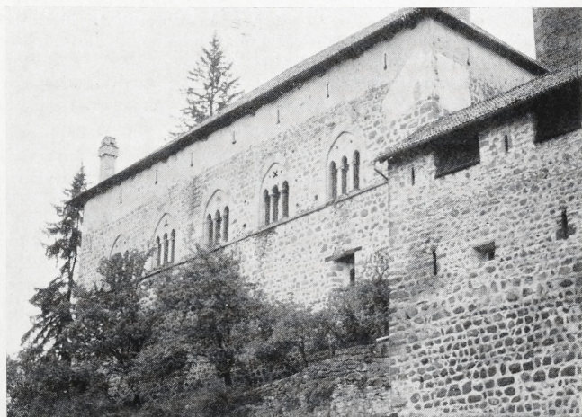
Abb. 2. Reinegg bei Samthein, Südtirol, Westseite des Palas (Mitte 13. Jh.). Aufnahme Th. Biller.
