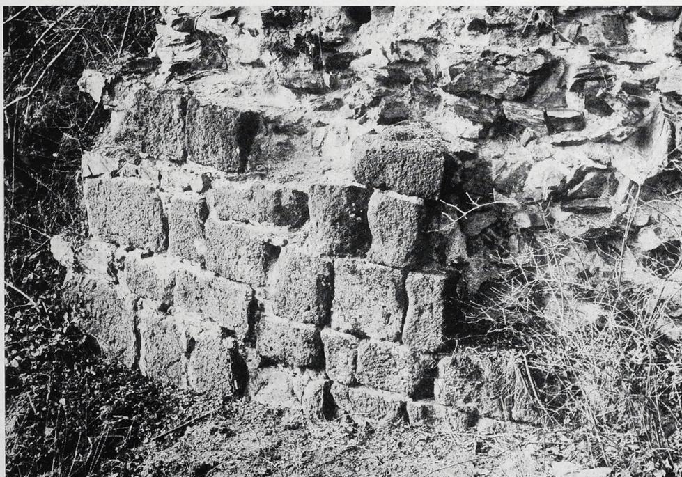
Abb. 4. Hammerstein am Rhein. Östliche Ecke des Kernbaues. Mauerwerk, verkleidet mit Basaltquadern, 11. Jahrhundert? (Foto des Verfassers)
