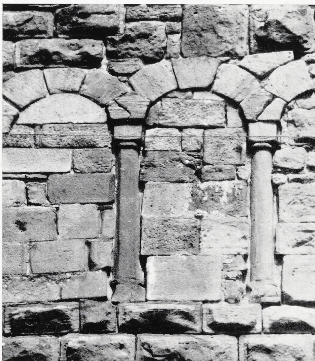
Abb. 4. Die Palasarkaden in der Südmauer des östlichen Hochschlosses. Die rechte Basis zeigt eine Echhülse. Foto Erwin KERN
