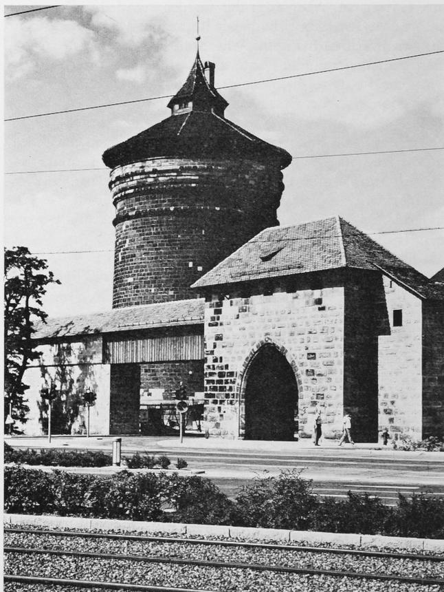
Abb. 5. Nürnberg. Spittlertor. Rechts das mittelalterliche Tor, links die 1967 erweiterte Öffnung (Foto: Hochbauamt Nürnberg, 1967)
