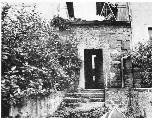
Abb. 9. Biebelried. Stelle des ehemaligen Burgtores mit dem noch vorhandenen östlichen Gewänderest in der südlichen Ringmauer
