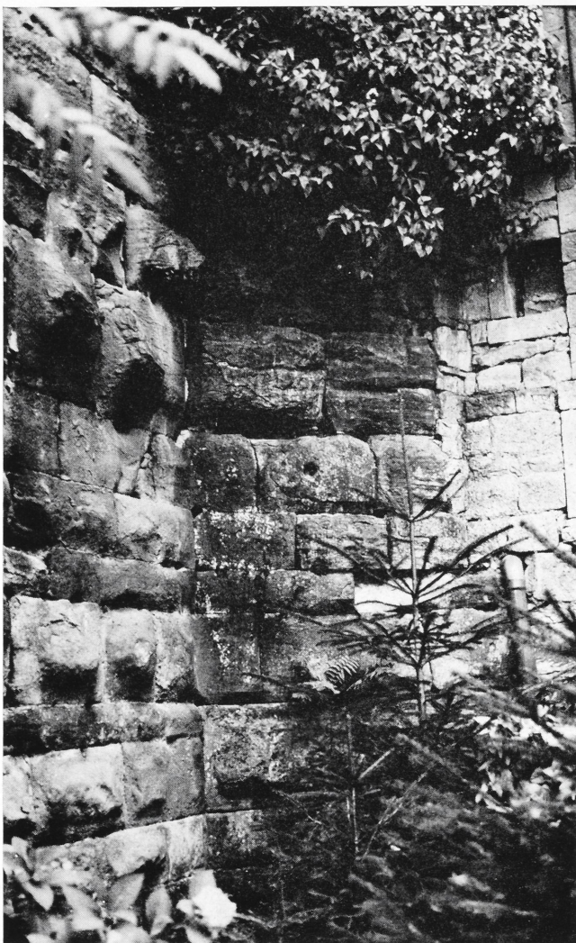
Abb. 7. Biebelried. Unterer Teil des nordöstlichen Stützpfelers
