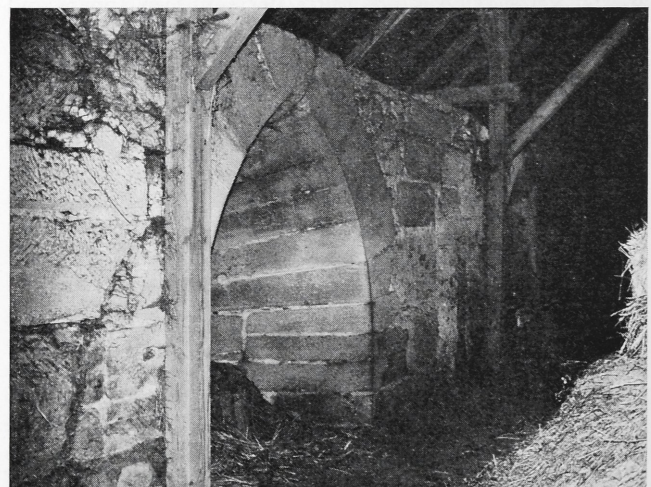
Abb. 14. Biebelried. Oberer Teil der beiden südlichsten Schießscharten in der östlichen Ringmauer, Hofseite
