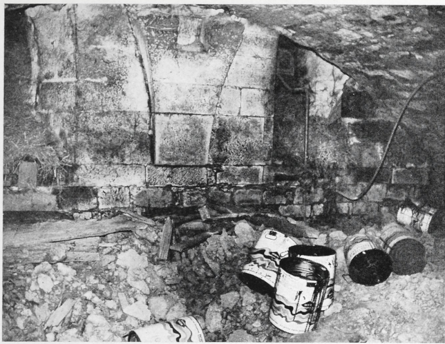
Abb. 11. Biebelried. Konsole mit rechteckiger Aussparung und zwei Schießscharten in der südlichen Innenwand des südwestlichen Wohngebäudes, teilweise verdeckt durch das nachträglich eingezogene Tonnengewölbe
