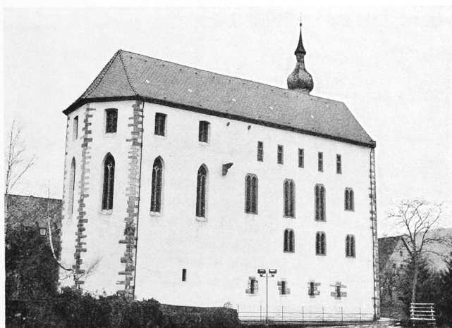
Abb. 12. Ansicht der Templerburg Neckarelz/Kreis Mosbach mit großen Wehrfenstern und einfachen Schießscharten im Tiefgeschoß
