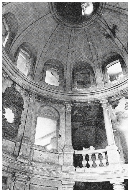
Abb. 2. Hospitalkapelle in Landau/Pfalz. Innenansicht vor dem Abbruch (Foto: Erwin Hoffmann)
