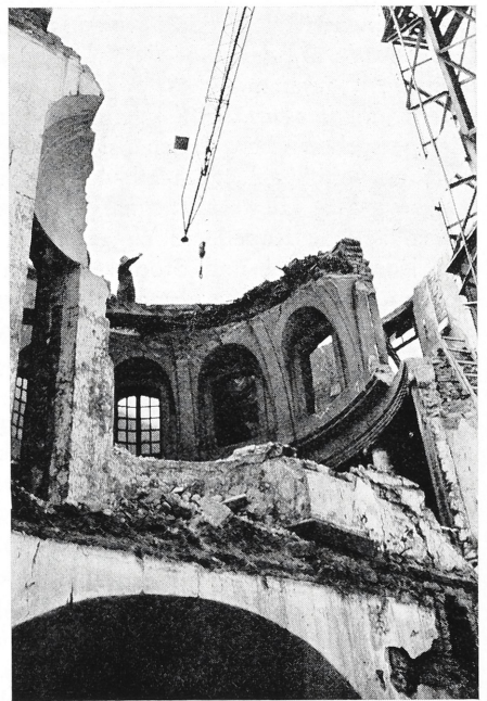
Abb. 3. Abbruch der Hospitalkapelle in Landau, 10. 4. 1964 (Foto: Erwin Hoffmann)
