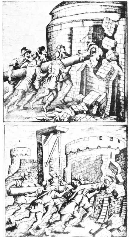
Abb. 4. Widdereinsatz gegen Mauern
