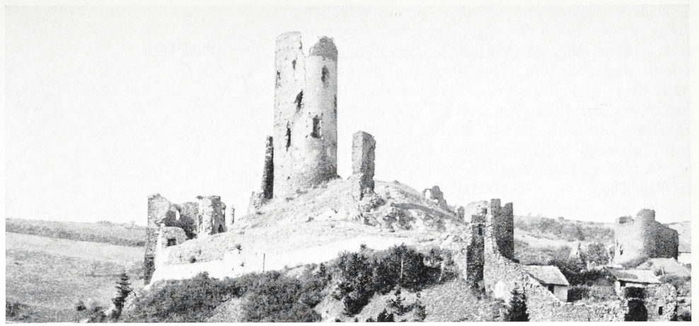
Abb. 32. Burg Monreal, Zustand vor der Restaurierung
