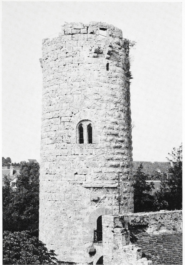
Abb. 6. Krautheim. Bergfried, Ansicht vom Treppenturm (Südwest), mit Bergfriedeingang, Doppelfenster und Resten von Gußerkern am Turmhaupt. Foto Dankwart Leistikow, ca. 1965
