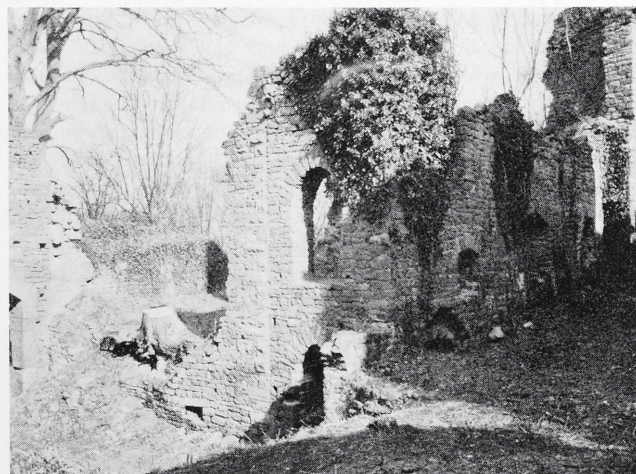
Abb. 18. Burg Freudenberg. Ruine des zweiten Gebäudes in der Kernburg
