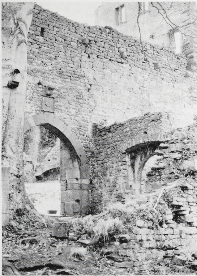
Abb. 17. Burg Freudenberg. Tor der Kernburg und drittes Tor der Toranlage. Oben in der Ringmauer die Konsolen eines hölzernen Wehrganges?
