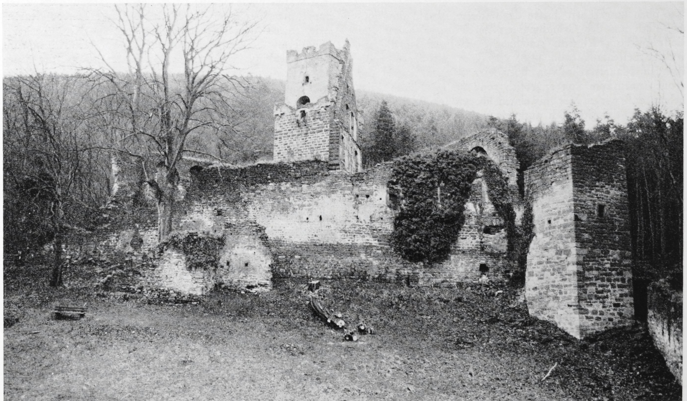
Abb. 10. Burg Freudenberg. Blick vom Batterieturm auf die Oberburg; rechts der Turm der Toranlage
