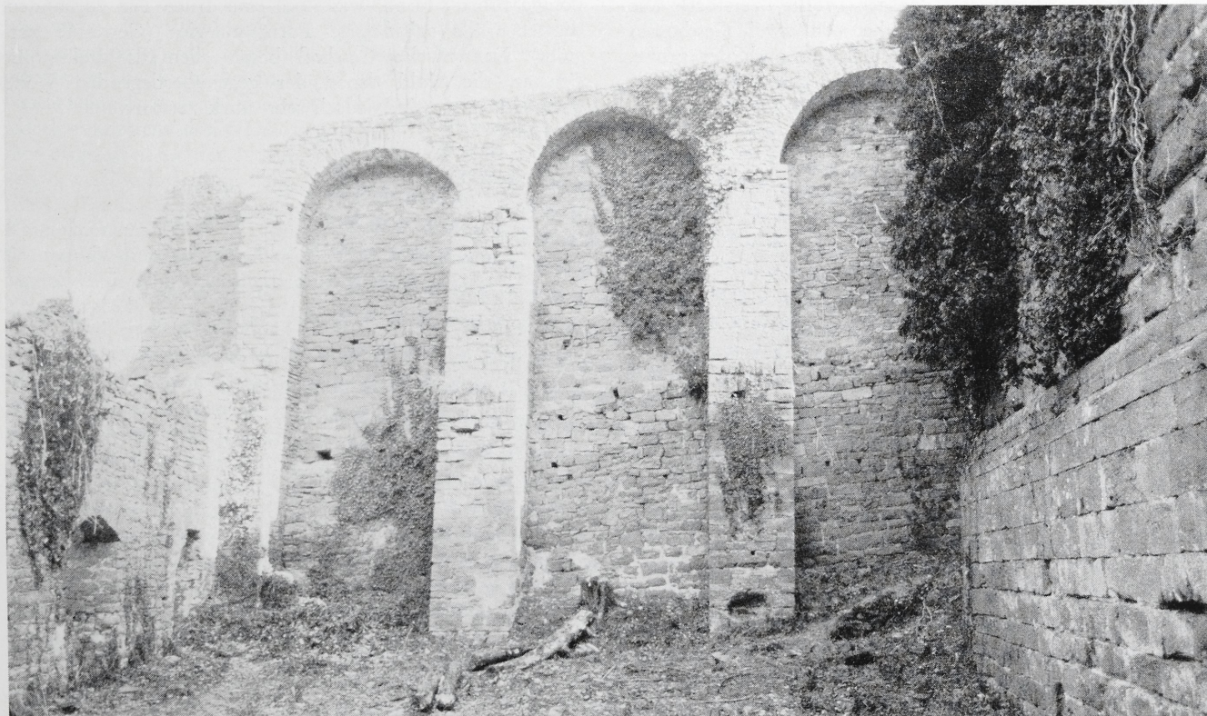
Abb. 11. Burg Freudenberg. Ringmauer der Kernburg von Westen; rechts der Sockel des Bergfriedes
