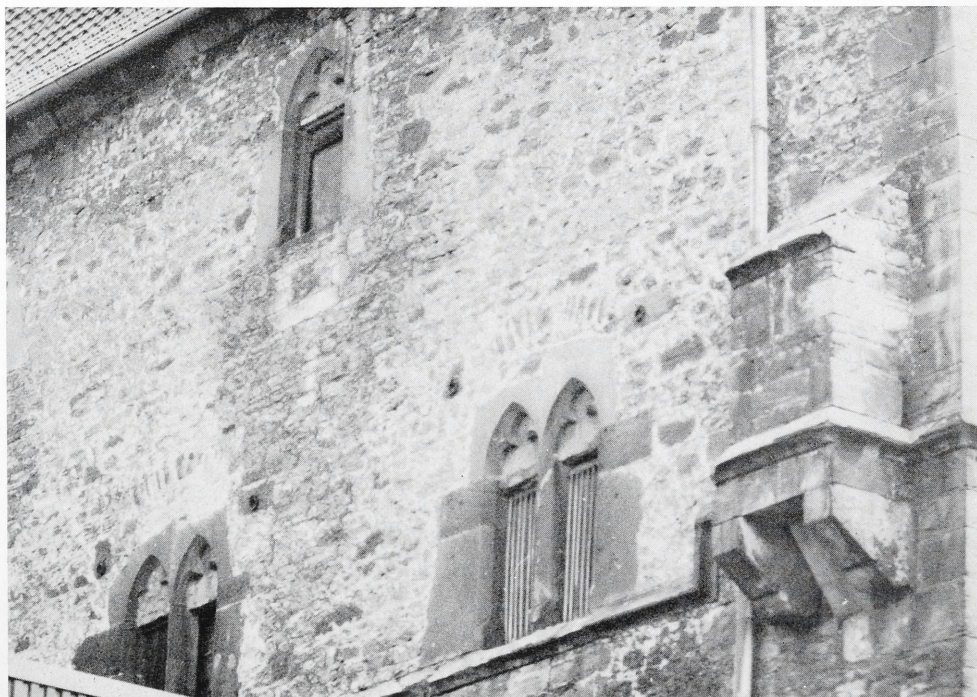
Abb. 11. Marienburg, Nordfassade des Palas mit Abtrittkerker
