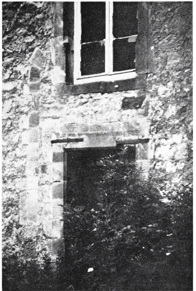
Abb. 9. Südeingang des ehemaligen Amtshauses. Links neben der Tür vermauertes älteres Gewände. Aufnahme Verf. 1977
