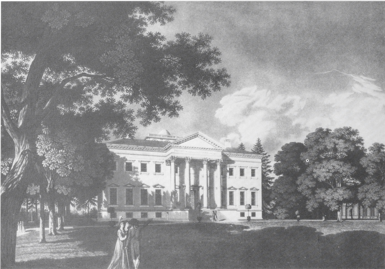
Abb. 1. Das Schloß zu Wörlitz. 1769–1773 von Erdmannsdorff errichtet. Farbige Aquatintablatt von Karl Kuntz. Chalkographische Gesellschaft zu Dessau, 1797
