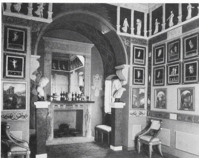
Abb. 14. Wörlitz. Villa Hamilton, Blick in das Kaminzimmer. 1791–1794 von F. W. v. Erdmannsdorff als gebaute Reiseimpression eingerichtet
