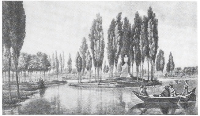
Abb. 16. Wörlitz. Rousseau-Insel. 1782 von F. W. v. Erdmannsdorff errichtet. Aquarellierte Zeichnung von Georg Melchior Kraus, um 1785
