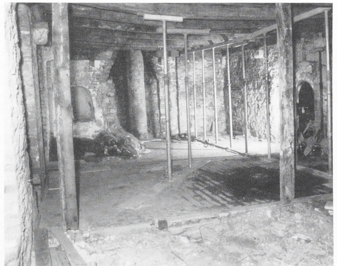
Abb. 3. Haus Herbede, ehemaliger Rittersaal, Foto: U. Kathagen, Witten
