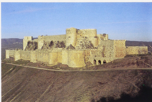
Abb. 3. Krak des Chevaliers. Eingangsseite
