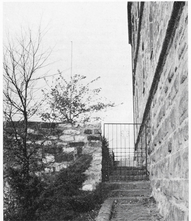
Abb. 22. Burg Giech, Ehemaliges Pförtlein, Bauzustand nach der Instandsetzung von 1972–74. Foto H. Scholz
