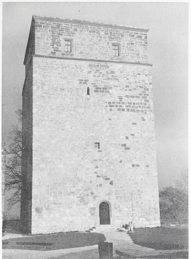
Abb. 19. Burg Giech, Bergfried nach der Instandsetzung. Der Zugang wurde im Rahmen des Gebatsellschen Schloßbaues um 1600 angelegt. Auf der gegenüberliegenden Seite befindet sich der Originaleinstieg auf halber Höhe. Foto vom Verfasser
