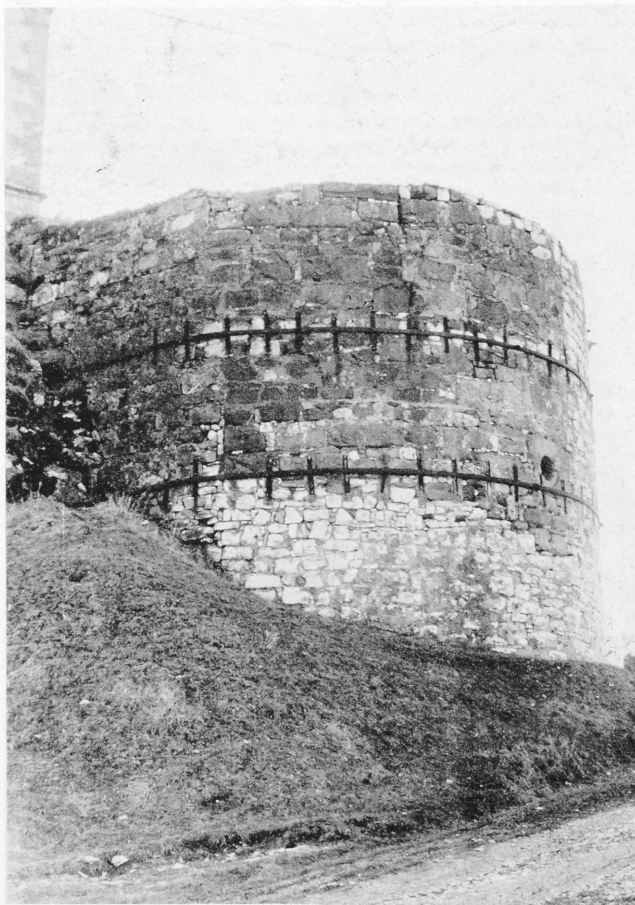
Abb. 13. Burg Giech, ehemaliger „Feulturm“ des Fürstbischofs Friedrich v. Aufseß vor der Instandsetzung. Unter der überwachsenen Anböschung Reste der ehemaligen Äußeren Toranlage, heute Parkplatz
