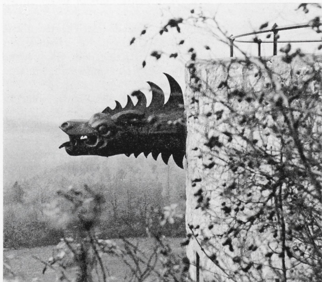
Abb. 27. Burg Giech. Der Feulturm nach der Instandsetzung (Detail). Foto vom Verfasser
