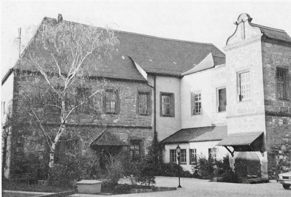
Abb. 20. Burg Giech, Innenhof mit Westbau nach der Instandsetzung. An der Verbindungsstelle zum Nordbau (hell verputzte Fläche) stand bis 1704 der Große Schneckenturm. Foto vom Verfasser
