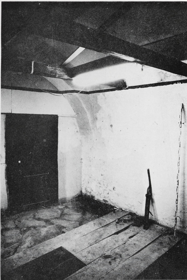
Abb. 1. Marksburg, Große Gewölbekammer. Blick zur Hofseite und schmalen Trennwand. Dielenboden und Fußboden aus Schieferplatten. Aufgenommen von Thomas Ludwig, 1.—3. Juli 1985, Negativnummer: = 428
