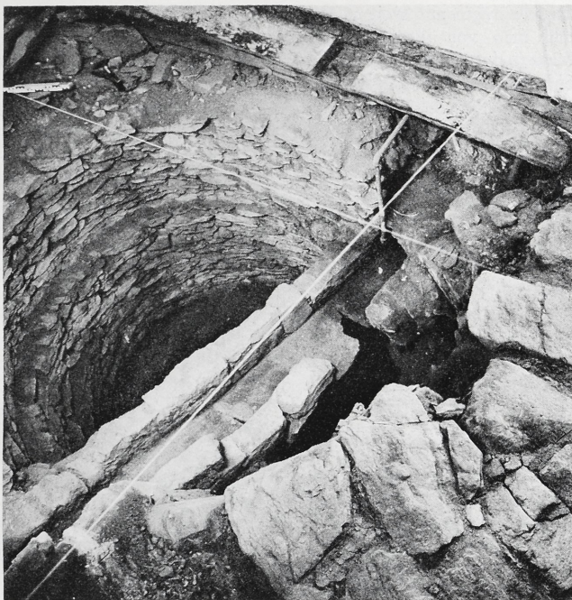
Abb. 7. Marksburg, Große Gewölbekammer. Nach Herausnahme des Dielenbodens und der Deckenbalken. Schacht mit der Wasserrinne. Blick zur Außenseite. Rechts der Fußboden aus Schieferplatten. Aufgenommen von Thomas Ludwig 1.—3. Juli 1985, Negativnummer: = 444
