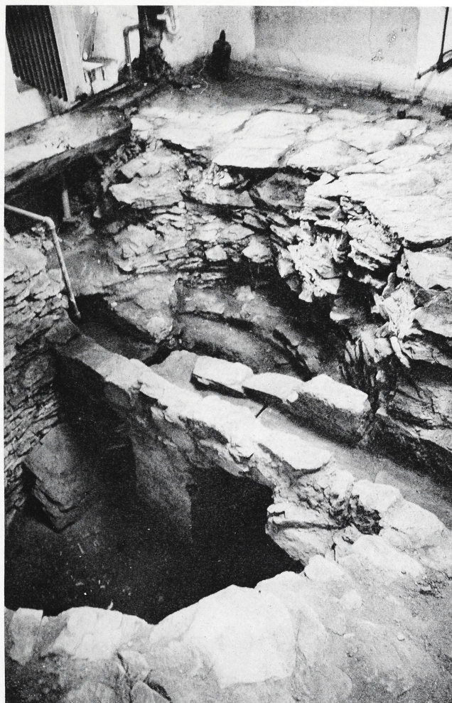
Abb. 8. Marksburg, Große Gewölbekammer. Nach Herausnahme des Dielenbodens und der Deckenbalken. Schacht mit der Wasserrinne, die in der Mitte auf einem Pfeiler liegt. Blick gegen die Außenseite und die Trennwand. Aufgenommen von Thomas Ludwig 1.—3. Juli 1985, Negativnummer: = 446
