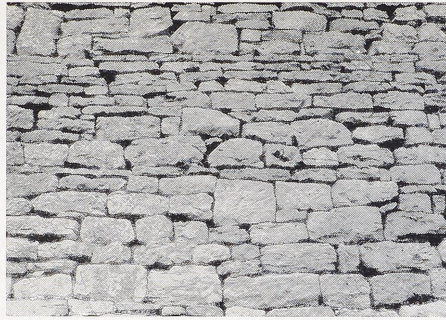
Abb. 3 Bruchsteinmauerwerk. Burg Brauneck (Kr. Mergentheim), Umfassungsmauer, Muschelkalk, 2. Viertel 13. Jahrh.
