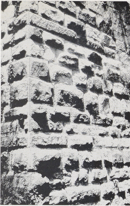
Abb. 3 Bruchsteinmauerwerk. Burg Brauneck (Kr. Mergentheim), Umfassungsmauer, Muschelkalk, 2. Viertel 13. Jahrh.
