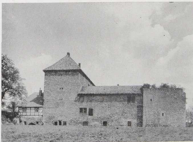
Ruine Steinbrück (Reg.-Bez. Hildesheim). Gesamtansicht von Westen, rechts der Berchfrit mit dem Wullenweber-Gefängnis
