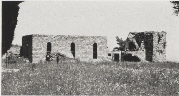
Abb. 2 Blick nach Osten auf den Palas und den Südostturm
