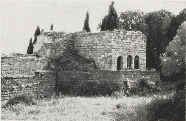
Abb. 4 Blick von Nordosten auf den Küchenbau und den Nordwestturm
