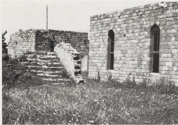
Abb. 10 Wirtschaftsbau, Freitreppe und Palas von Südwesten
